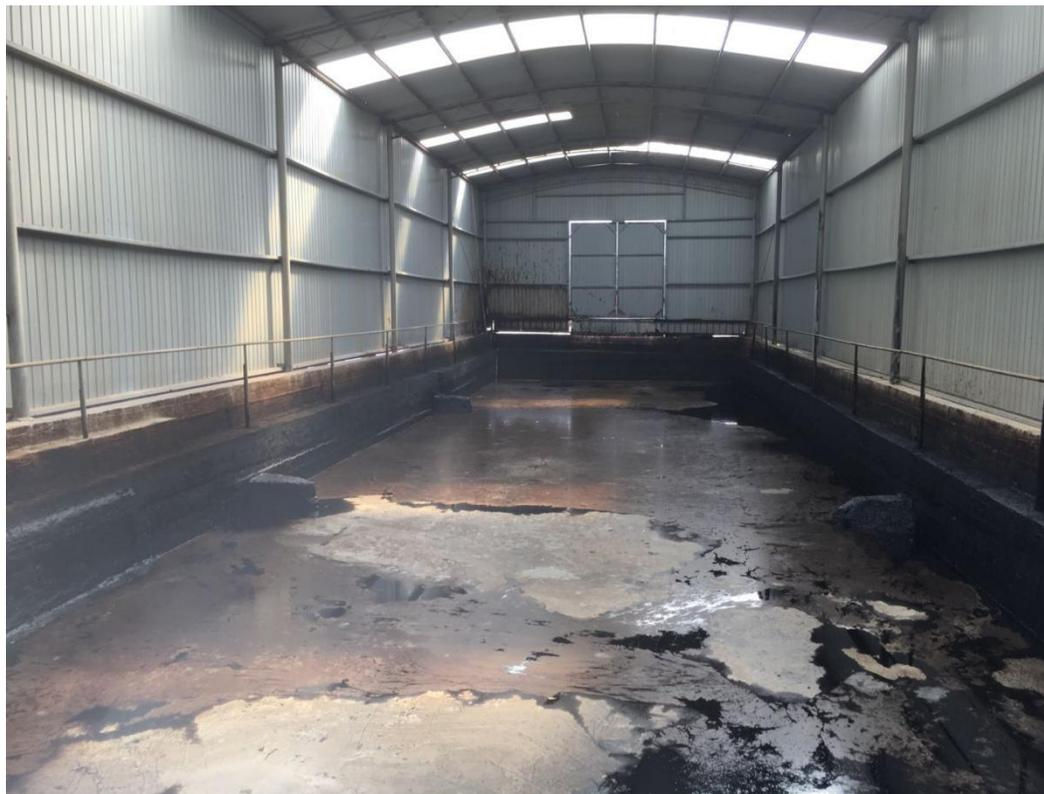
该回水净化池为 900m<sup>3</sup>,回水净化池主要贮存污油,池体四周均设有抗渗混凝土防渗处理措施,池体上方均有“三防”处理措施,并且公司有完善的运行管理,定期维护。
