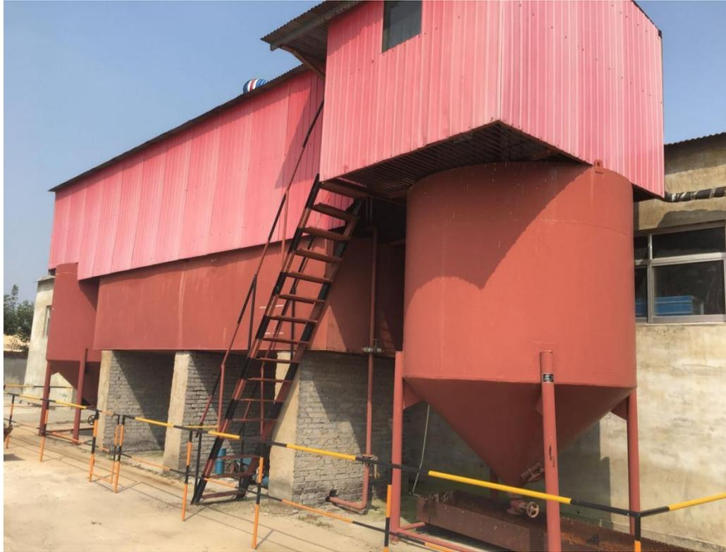
罐体无明显受损现象，儲罐底部和周边区域均有防滲，未设置围堰，地面可见处未进行硬化处理，有破损现象，儲罐无“跑、冒、滴、漏”现象。
