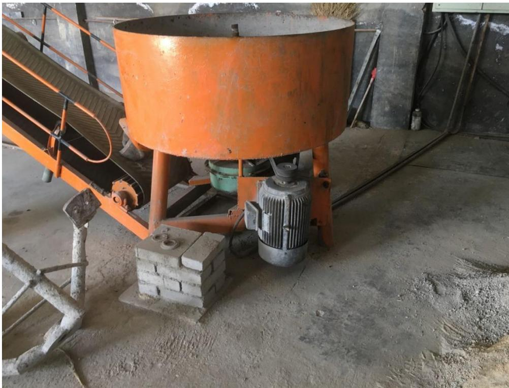
搅拌泵周围地面采用混凝土进行防渗，地面无裂缝，泵轴无“跑、冒、滴、漏”现象，定期对泵进行巡检，观测是否有泄漏痕迹。
